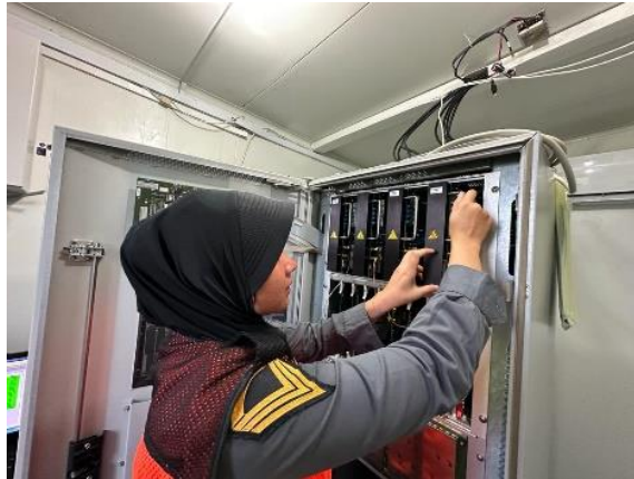
Gambar 18. Melepaskan Mod PA CLR dari raknya
