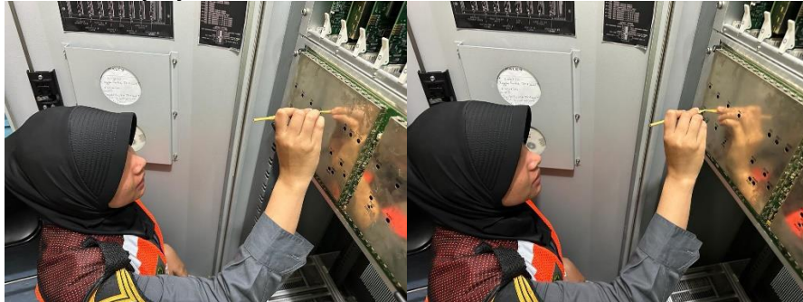
Gambar 24. Adjustment pada modul SOAC
