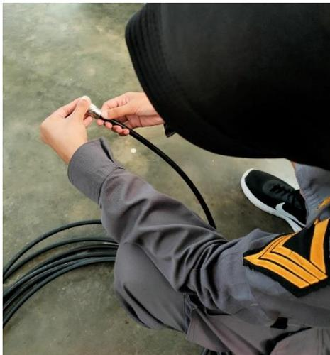
7. Setelah konektor kabel antena sudah terpasang dan terhubung ke antena, radio VHF APP frekuensi 124.0 MHz kemudian dihidupkan kembali.
