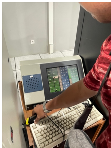
Gambar 15. Pengecekan output audio TX pada VCCS dan IDF
