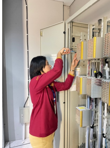
Gambar 12. Kroning konfigurasi pada MDF di ruang MER Sumber : Dokumentasi Penulis,2023
