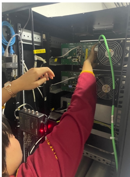
Gambar 9. Pemindahan antenna di VHF OTE DT100
