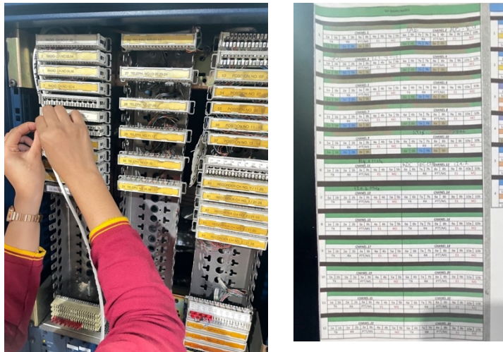
Gambar 13. Pengecekan kabel pada IDF Radio sesuai tabel di ruang MER
