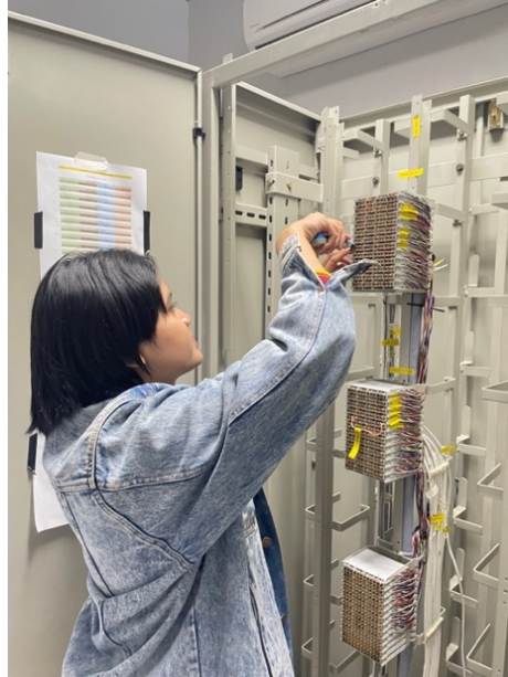
Gambar 14. Kronting konfigurasi pada IDF di lantai 6
