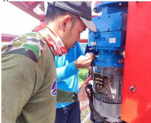
**Gambar 13.** Pemasangan Kabel *Power* pada motor radar
