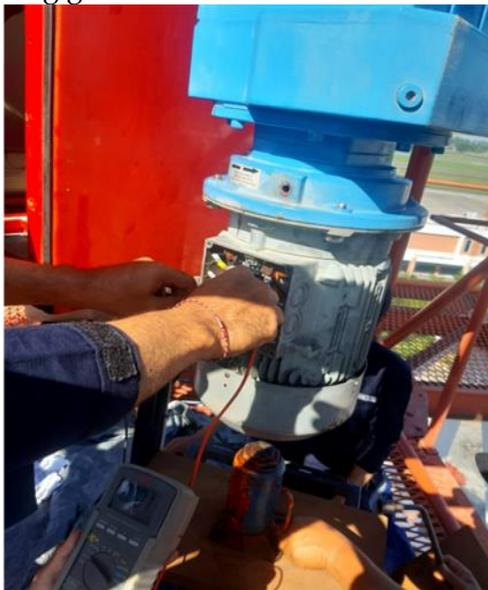
**Gambar 12.** Pemasangan *Gearbox* dan motor radar
