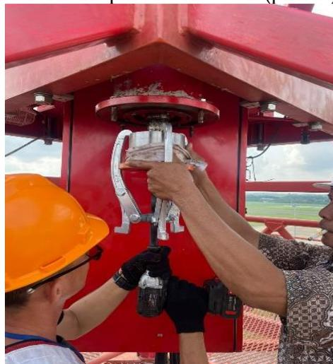
Gambar 9. Pemasangan *Freewheel Clutch*
