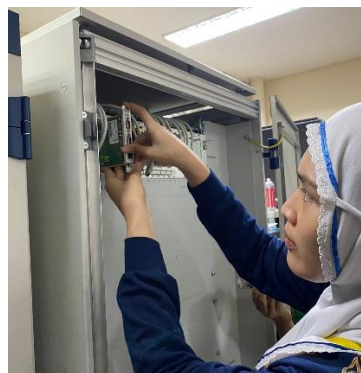
Gambar 12. Pemasangan Kembali Modul
