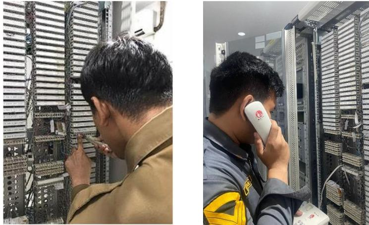
**Gambar 7.**Pengecekan pada Krone LSA
